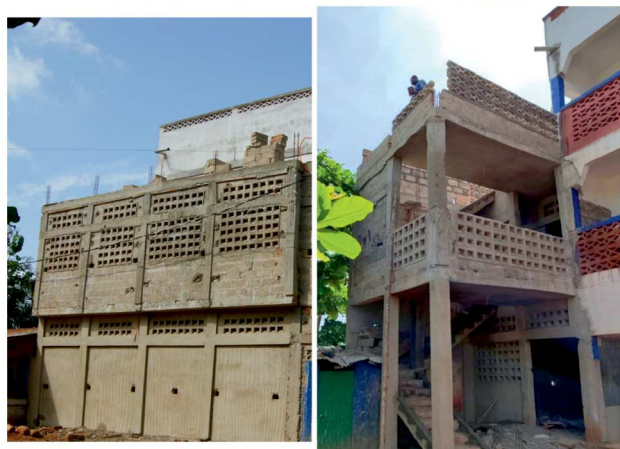
Schulbibliothek im Bau
